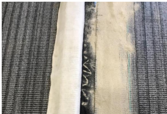
Fold en af bentonitmåtterne tilbage. Strø løs bentonit, hvor måtterne overlapper.
