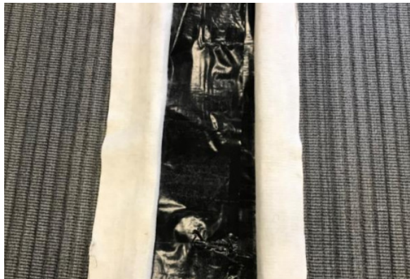
Fold bentonitmåtterne til side og læg plasten overlappende.
