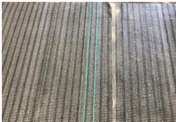
Fold den anden bentonitmåtte tilbage. Placer afstandsholderen i henhold til billedet på side 4.
